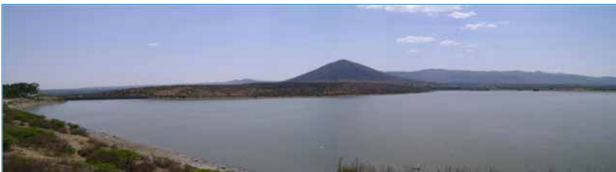
Figura 3.1. Vista Panorámica de la Presa Santa Catarina, en la Delegación Santa Rosa Jáuregui, Municipio de Querétaro. (Tomada: Marzo 5, 2009 por E. Ventura).
