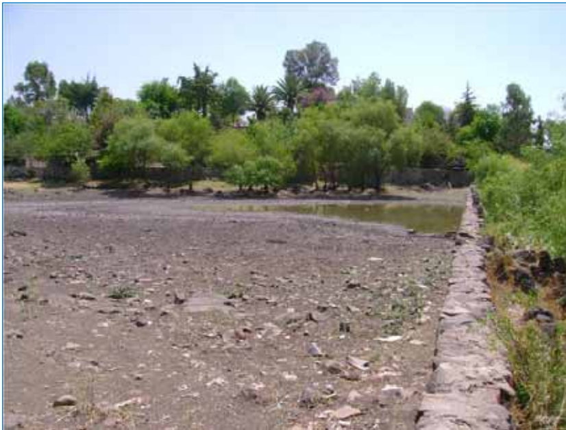
Figura 3.2. Bordo San Miguelito completamente azolvado, contaminado y no funcional para el control de avenidas en la Cuenca Urbana de la Zona Metropolitana de Querétaro.
