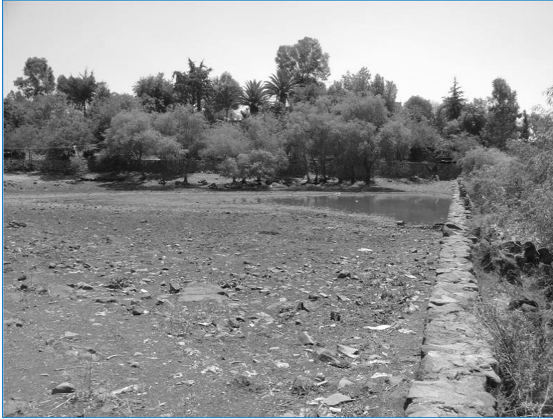
FIGURA 3.2. BORDO SAN MIGUELITO COMPLETAMENTE AZOLVADO, CONTAMINADO Y NO FUNCIONAL PARA EL CONTROL DE AVENIDAS EN LA CUENCA URBANA DE LA ZONA METROPOLITANA DE QUERÉTARO.
