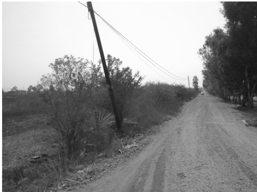
VISTA DEL CAMINO DE ACCESO AL POZO (TERRACERIA).
