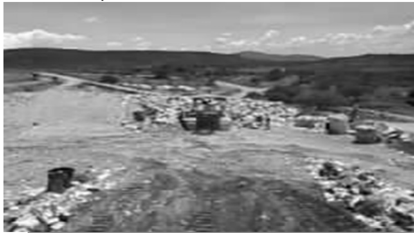
Figura 14.- Sitio de disposición final Tiradero Controlado “San José de los Trejo”
